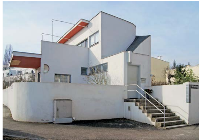
B // Eckhaus von Hans Scharoun, Weissenhofsiedlung, Werkbund-Ausstellung 1927 //
